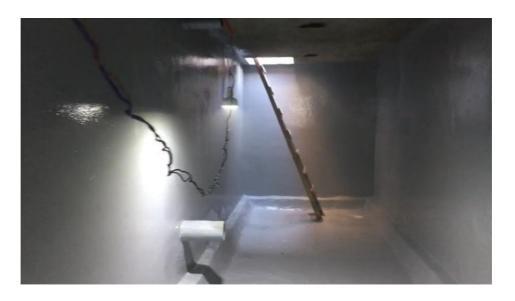
12) Drinking water tank System: Primer GC, Polyurea Rayston. Surface:  $850 \text{ m}^2$  (1.500  $\text{m}^3$ ).
