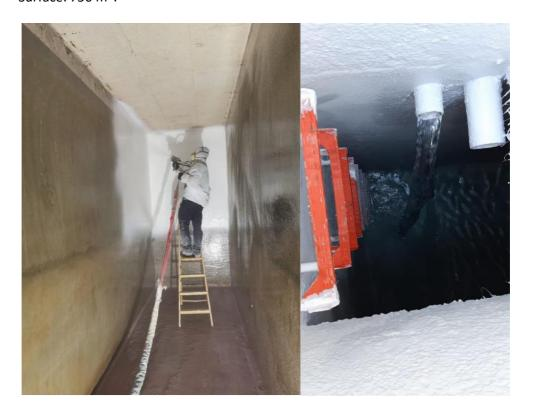
10) Drinking water tank System: Primer GC, Polyurea Rayston. Surface:  $455 \text{ m}^2$ .
